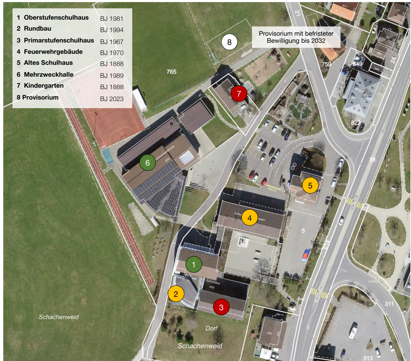
Luftbild Schulanlage Stein mit Instandsetzungsbedarf (Ampelsystem)
